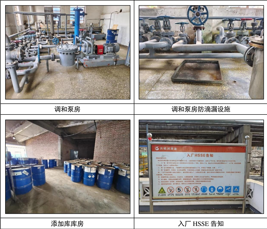
图 4-5 现场踏勘照片
